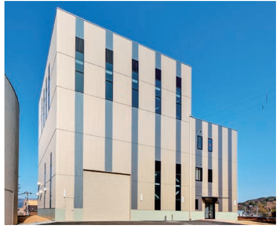
敦賀事業本部敷地内に整備された「ふくいスマートデコミッションング技術実証拠点」。
